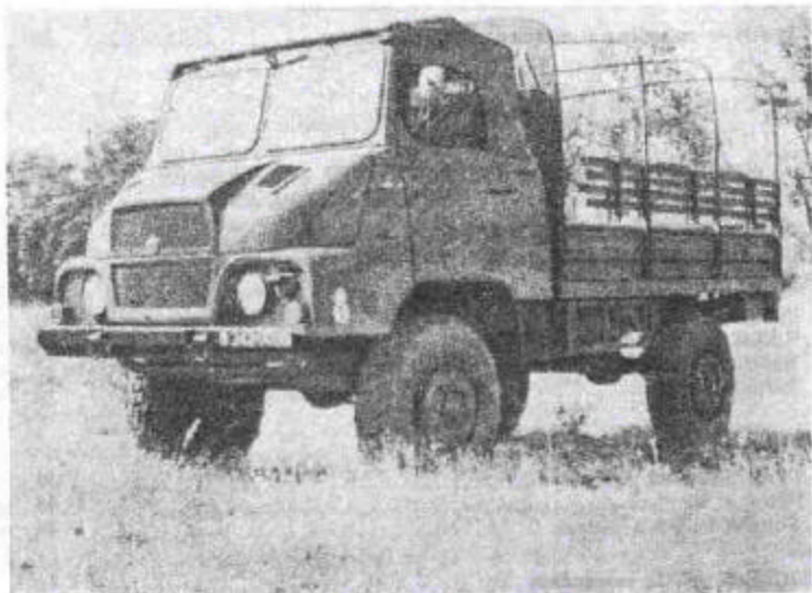
Fig. 1. — Camionnette SIMCA-MARMON 4 x 4, 1 500 kg, type MH 600 BS (vue d'ensemble)
